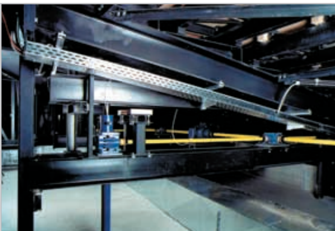
Werkbild: SBS Bühnentechnik GmbH Mehrspindelhubanlage (Hochleistungs- Spindelhubelemente HSE) mit Sicherheits- einrichtung gemäß VBG 70 (BGV C1) zur Saalpodienverstellung im Kulturzentrum Frankfurt/Oder. Die Synchronisation erfolgt über Kegelradgetriebe und Gelenkwellen.
